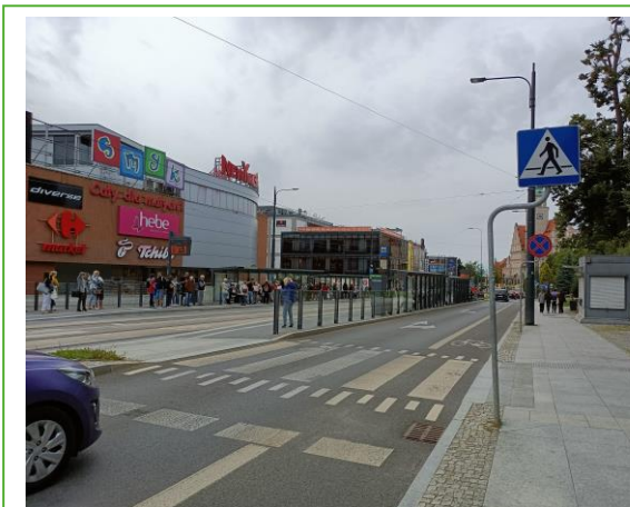
Rys. 6.25 Podnoszenie poziomu brd pieszych i rowerzystów – wyniesione przejście dla pieszych i wydzielony pas dla rowerzystów.
