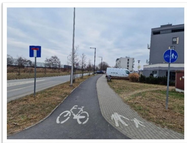
Fotografia 5. Nawierzchnia asfaltowa drogi dla rowerów
