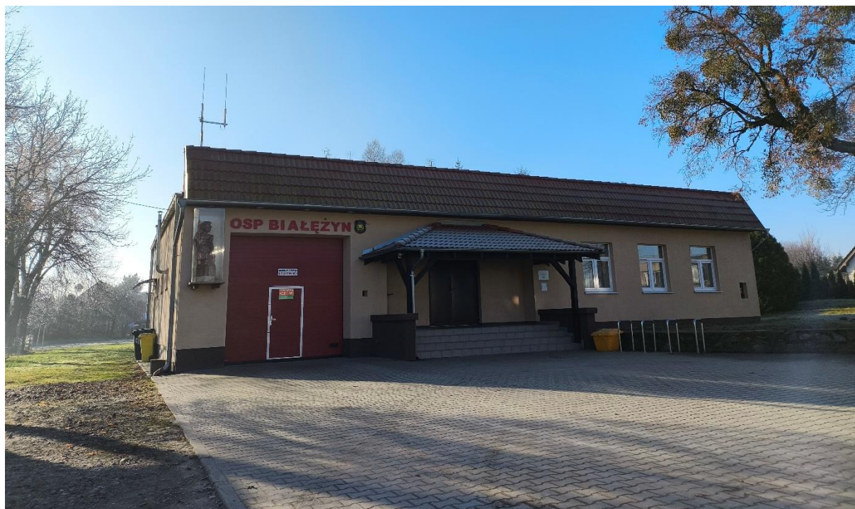
Fot. 11. Remiza OSP z funkcją świetlicy w Białężynie (wymagająca rozbudowy)
