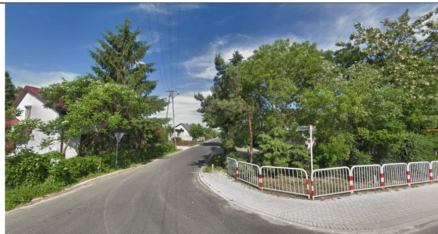
Fot. 6. Widok na ul. Pasieczną z ul. Bnińskiej
