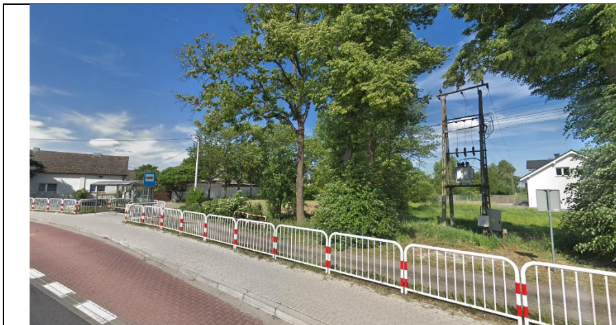
Fot. 5. Widok na teren opracowania z ul. Bnińskiej
