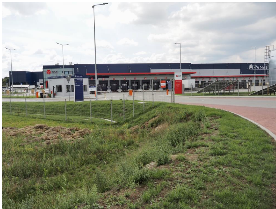
Rysunek 2a. Aktualne zagospodarowanie terenu – centrum logistyczne DPD.
