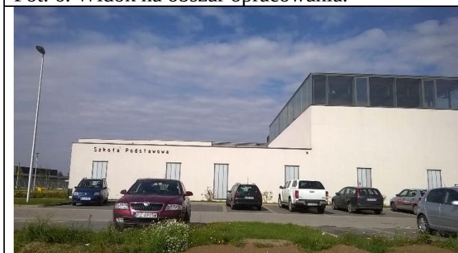
Fot. 8. Widok na Szkołę Podstawową w Kamionkach, położoną w sąsiedztwie obszaru projektu planu.
